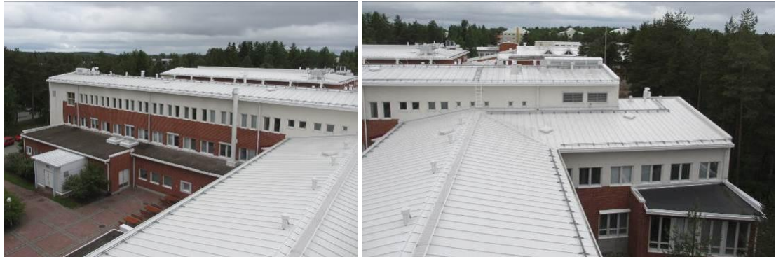
Kuvat 25 a ja b. D-siiven etelä-, itä – ja pohjoispäädyn vesikattoja kuvattuna E-siiven vesikatoilta.
