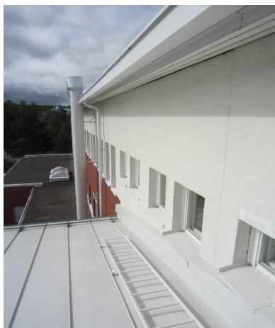
Kuvat 30 a ja b. Ohutrappauksessa on veden valumajälkiä räystäään alapuolella. Ikkuna/ulkoseinäarakenteen liitoskohdassa on rako. Ikkunoiden puuosien maali hilseilee.
