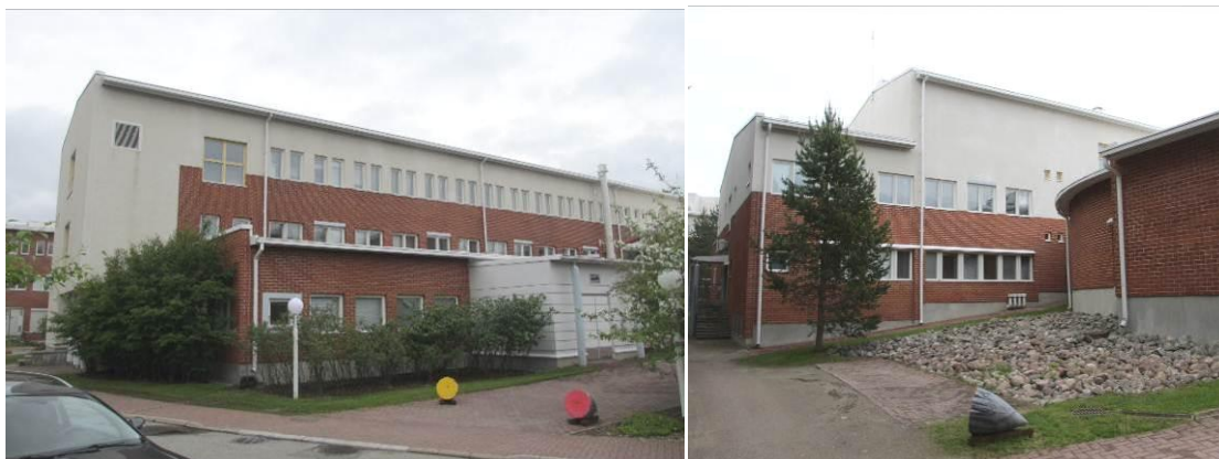
Kuvat 32 a ja b. Vasemmanpuoleisessa kuvassa on D-siiven kolmikerroksisen osan eteläpääty, jossa pihamaa on melko tasainen. Oikealla on kuva pohjoispäädystä, jossa maan pinta viettää pois päin rakennuksesta.
