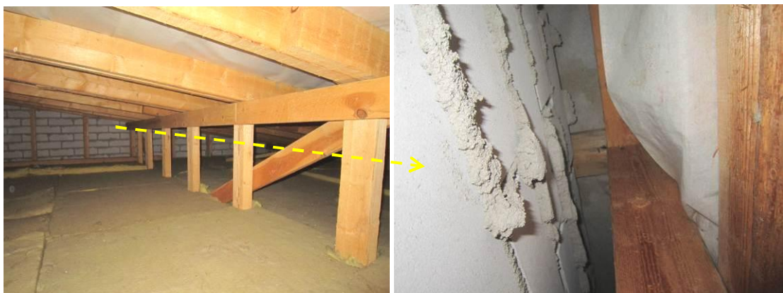
Kuvat 27 a ja b. D-osan yläpohjan ilmatilan puurakenteet, lämmöneriste ja aluskate olivat hyväkuntoiset. Oikealla on lähikuva päätyseinän kohdalta, jossa aluskate ulottuu ulkoseinän päälle.
