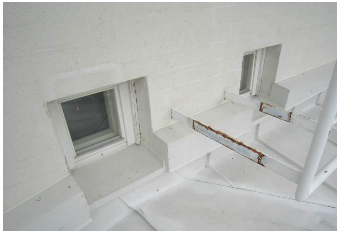
Kuvat 30 a ja b. Ohutrappauksessa on veden valumajälkiä räystäään alapuolella. Ikkuna/ulkoseinäarakenteen liitoskohdassa on rako. Ikkunoiden puuosien maali hilseilee.
