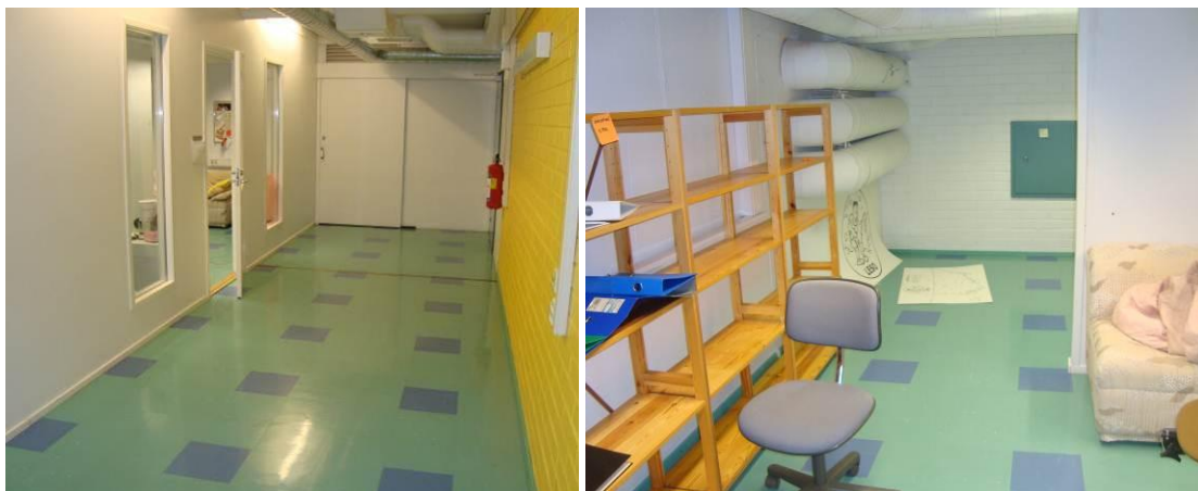
Kuvat 2 a ja b. Lattiapinnat olivat hyväkuntoisia vuonna 1994 rakennetussa kellarikerroksessa.
