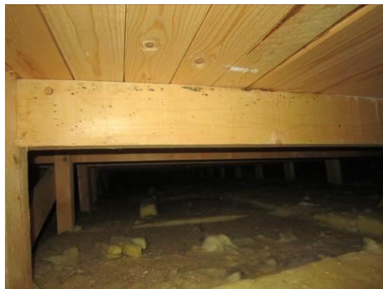
Kuvat 25a ja b. Vanhan osan bitumikermikaton rakenteet olivat kuivat ja siistit huoneen A242 kohdalle tehdyssä rakenneavauskohdassa. Lämmöneristeenä on mineraalivillalevyjä.
