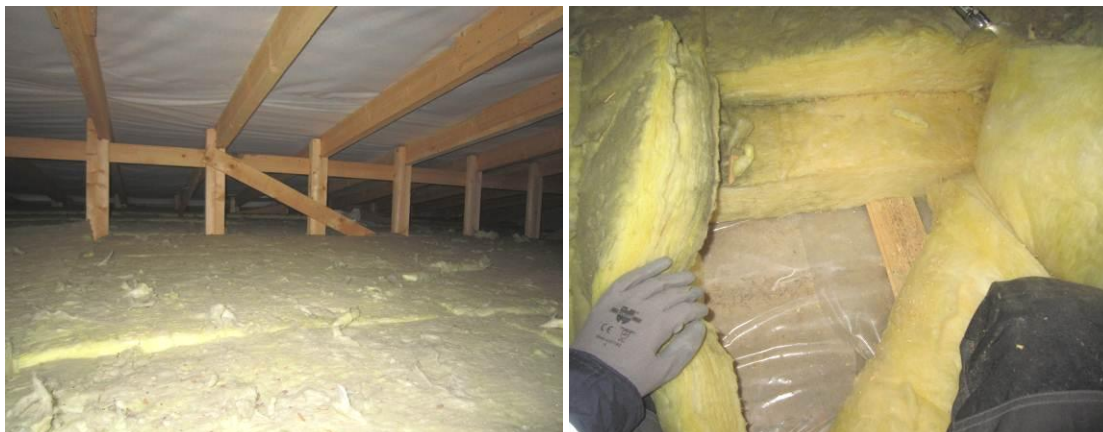
Kuvat 20a ja b. A-siiven vanhan osan yläpohja oli siisti ja kuiva. Limitettyjen mineraalivillalevyjen alla on höyrynsulkumuovikalvo.
