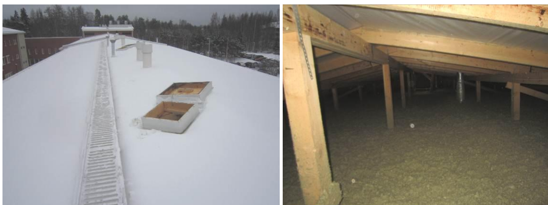
Kuvat 21a ja b. A-siiven uuden osan vesikatto ja yläpohja. Yläpohja oli siisti ja kuiva. Puhallusvillakerroksen, n.400 mm alla on höyrynsulkumuovikalvo.
