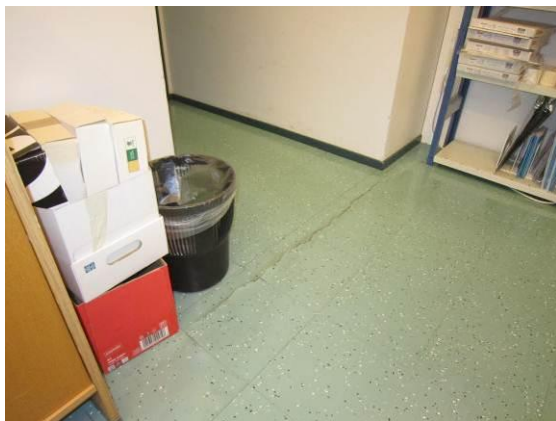
Kuva 14a ja b. Välipohjassa on rakenteen läpi ulottuva halkeama huoneessa A222. Samassa kohdassa käytävällä liikuntasauman elastinen saumamassa on irronnut saumasta.
