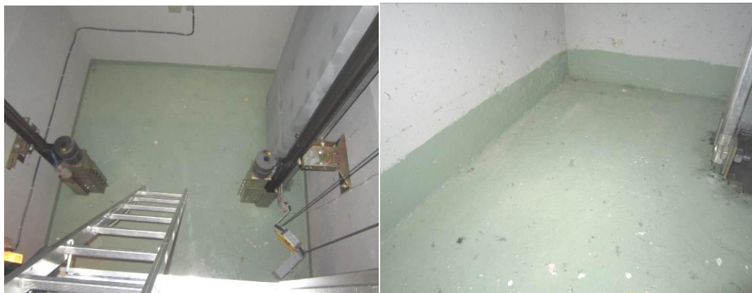
Kuvat 7 a ja b. Hissikuilun pohja oli siisti ja kuiva. Pohjan pinnoite on paikoitellen irronnut, mutta muuten hyväkuntoinen.
