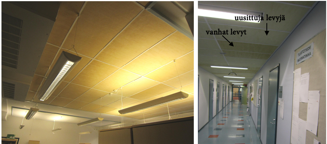
Kuvat 16 a ja b. Alakattojen kellertyneitä ja ikääntyneitä tekstiilipintaisia mineraalivillalevyjä on vaihdettu käytävillä ja huonetiloissa.
