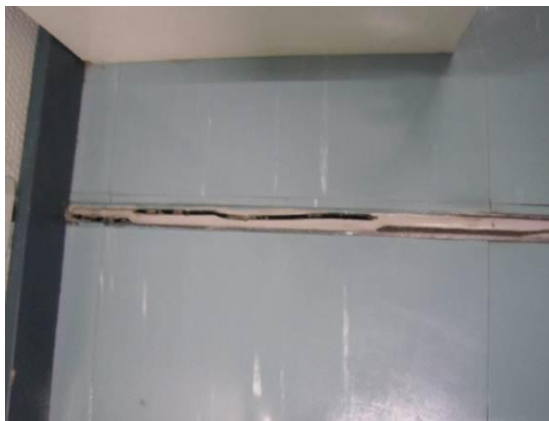
Kuva 14a ja b. Välipohjassa on rakenteen läpi ulottuva halkeama huoneessa A222. Samassa kohdassa käytävällä liikuntasauman elastinen saumamassa on irronnut saumasta.
