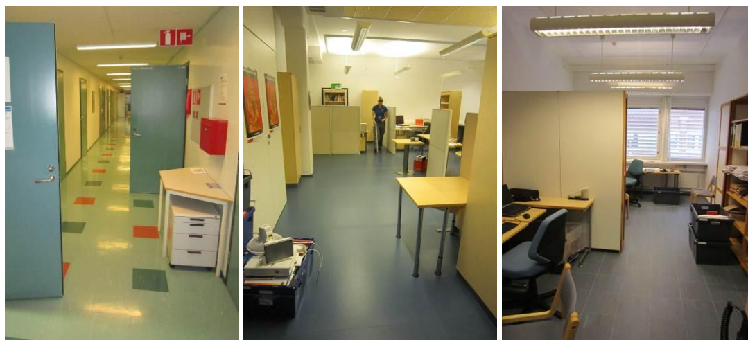
Kuvat 4a, b ja c. Vasemmalla vanhan osan alapohjan kvartsivinyylilaatoitus YTHS:n käytävällä. Keskellä huoneen A118 asennuslattian muovimatto. Oikealla huoneen A116 keraaminen laatoitus.
