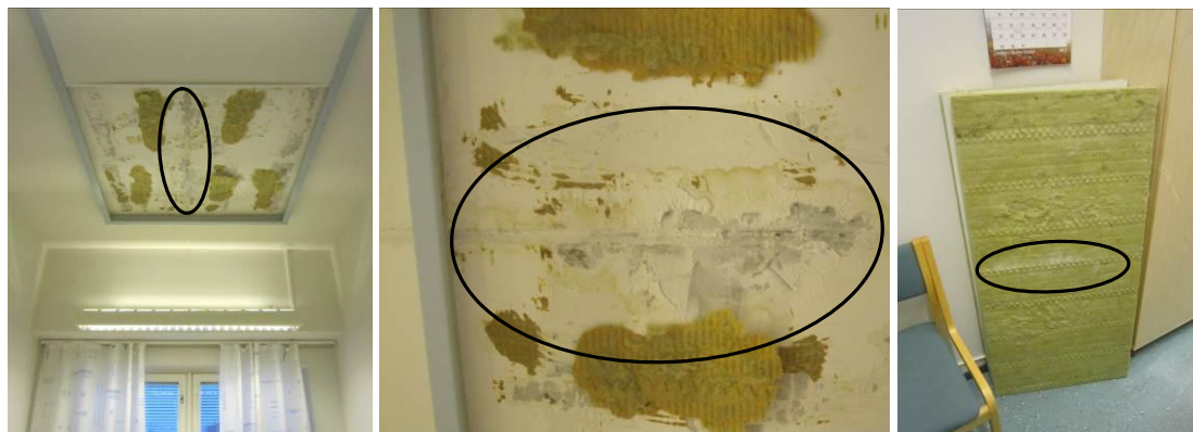
Kuvat 23a, b ja c. Tilan A234 vuotojäljen kohdalta mineraalivillasta otetussa materiaalinäytteessä ei ollut mikrobikasvua.
