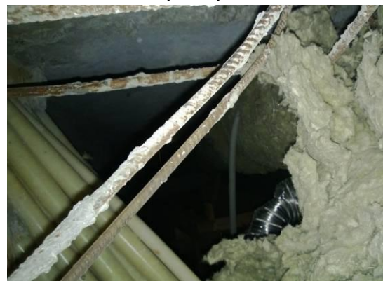
Kuva 26. ATK-luokan tarkastusluukusta näkymä tekniikkakuiluun
