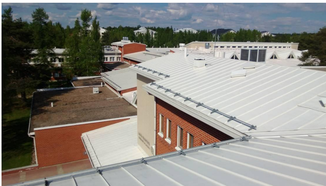
Kuva 28. C-siiven rivipeltikatto länteen päin katsottaessa.
