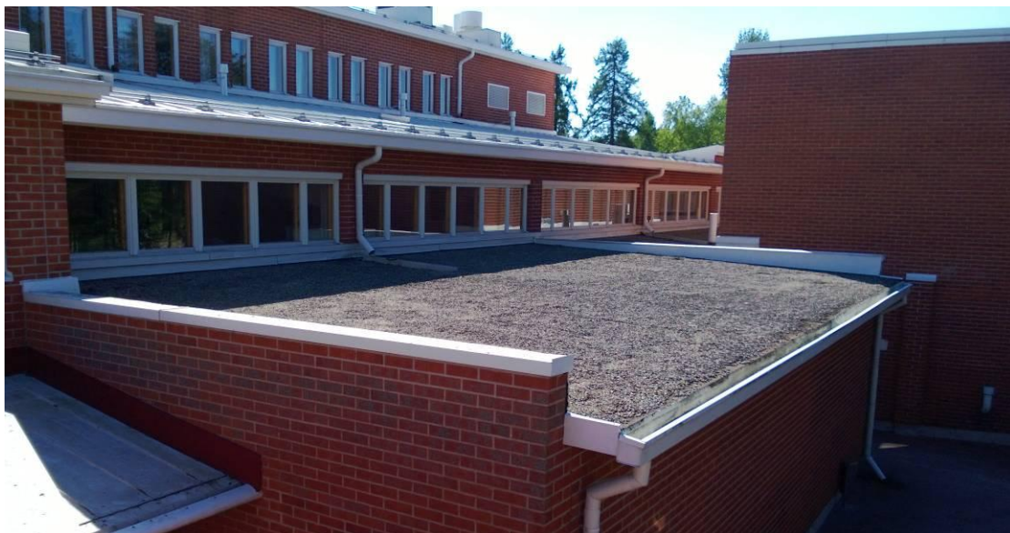
Kuva 30. C-siiven bitumikermikatto auditorion vieressä.
