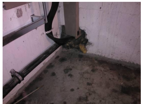
Kuva 10. Hissikuilun pohjalla on läpivienti kellaritilaan. Läpivienti on tiivistetty mineraalivillalla.
