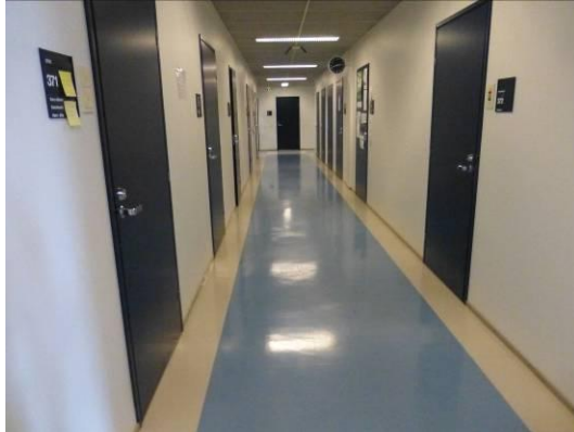
Kuva 21. Käytävillä (C224) ja huoneissa lattianpintamateriaalina on pääosin hyväkuntoinen kvartsivinyylilaatoitus.
