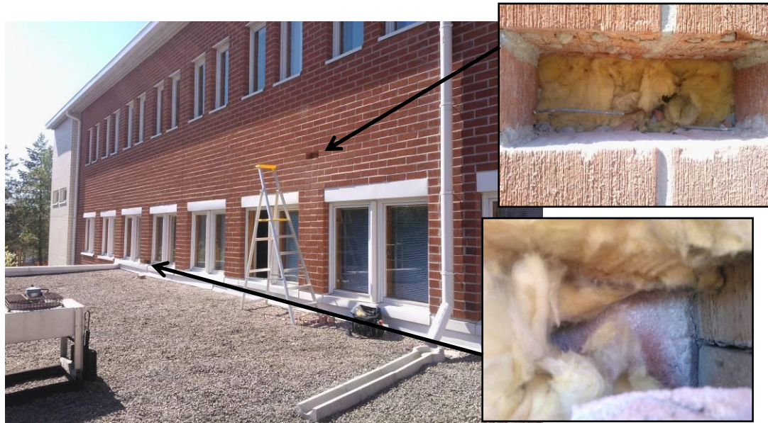
Kuva 17 a, b ja c. Idän puoleisen ulkoseinän eristeen kuntoa tarkasteltiin kahdesta kohdasta irrottamalla julkisivuverhoustiili (RA3 ja RA4). Rakenneavauksien ja analyysitulosten perusteella ulkoseinän eriste on hyvässä kunnossa.
