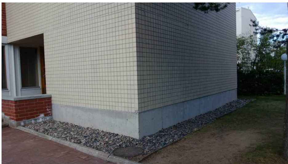
Kuva C. Muun muassa C-siiven eteläosan porrashuoneen perusmuurin ulkopinnassa on salaojituserros.
