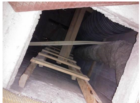
Kuva 24. IV-konehuoneen (C374) tekniikkakuilussa on pinnoittamatonta mineraalivillaa. Kuilusta on ilmayhteys alapuoliseen ATK-luokkaan (C256) ja sisääntuloaulaan (C125).
