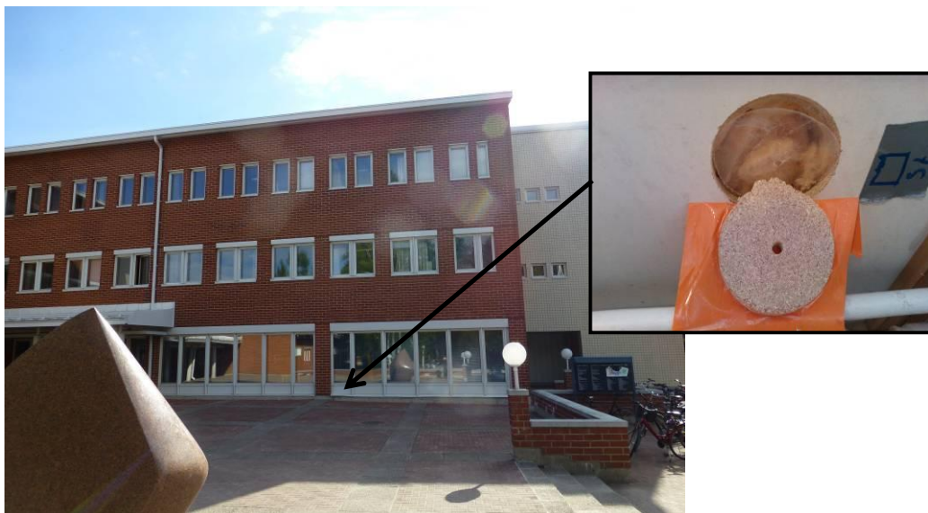
Kuva 15 a ja b. Ruokalan (C182) levyrakenteisessa ulkoseinässä on höyrynsulkumuovi (RA1).
