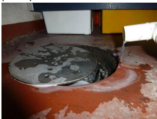
Kuvat 5 ja 6. Siivoajien huoltotilan (C128-132) lattiakaivon liitos on epätiivis.
