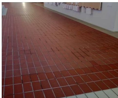
Kuva 4. Aulan (C125) tiililaattalattian saumoihin jää runsaasti pesuvettä lattiapesun yhteydessä
