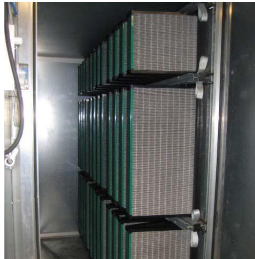
Kuva 16. Petronella -ravintolan keittiö, jossa jälkikäteen asennetut ilmanjähdyttimet.
