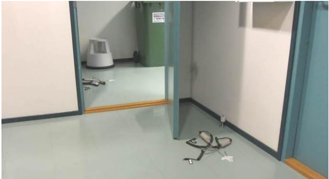
Kuva 7. Viiltokosteusmittaukset ensimmäisen kerroksen maanvastaisessa alapohjassa tiloissa E147 ja E104.
