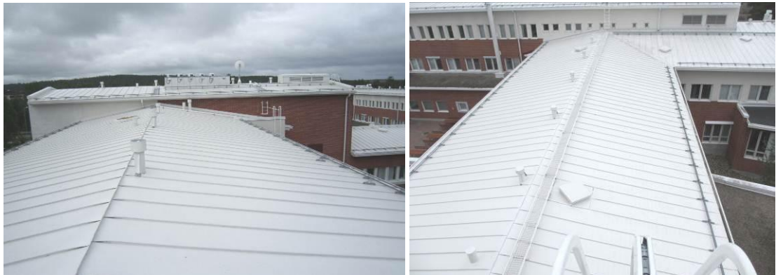
Kuvat 26 a ja b. Peltikattojen pinnoitteet ja katoille asennetut kattovarusteet ovat hyväkuntoiset. Peltikattojen harjalle on asennettu alipainetuulettimia yläpohjan ilmatilan tuuletuksen parantamiseksi.
