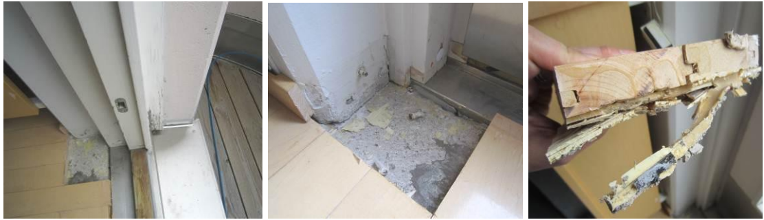
Kuvat 23 a ja b. Parvekkeen kohdalle tehdyssä rakenneavauksessa E3.4 rakenteet todettiin kuiviksi.
