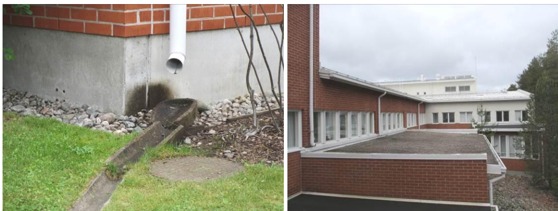
Kuvat 28 a ja b. Sadevedet ohjataan syöksytorvissa joko alempien bitumikermikattojen pinnoille tai maanpinnalle.
