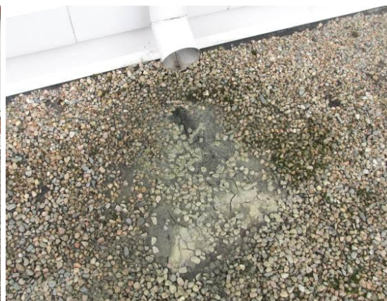
Kuvat 29 a ja b. Syöksytorvien kohdalla sorakerros on siirtynyt pois ja bitumikermi on halkeamia. Pellityksen ylösnoston kohdalla ohutrappaus on irronnut seinässä.
