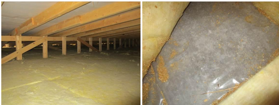
Kuvat 27 a ja b. Kaikkien peltikattojen yläpohjan ilmatilat olivat kuivia ja siistejä. Tuuletus toimii hyvin räystäiden kautta. Oikealla mineraalivillalevyjen alla oleva hyväkuntoinen höyrynsulkukalvo.
