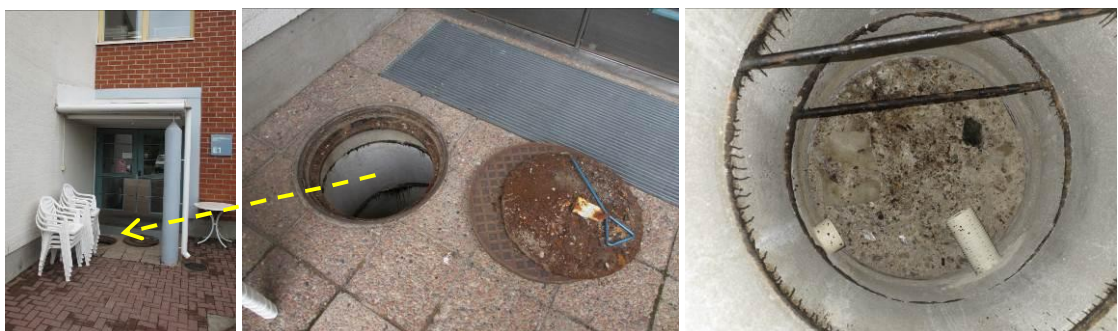
Kuva 35. Salaojaverkoston tarkastuskaivon pohja oli kuiva. Tarkastuskaivon kannesta pohjaan on noin 3200 mm.
