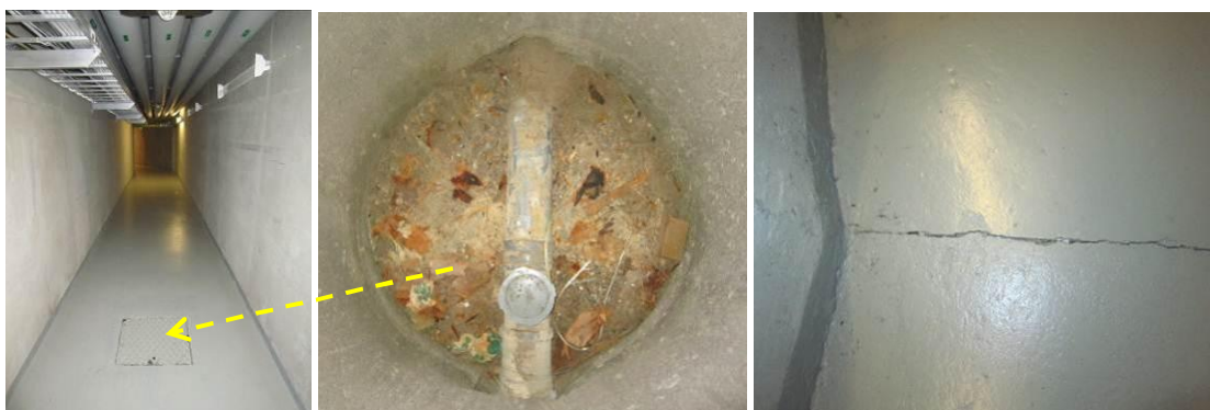
Kuvat 6 a, b ja c. Putkitunneli on kuiva, lämmin ja siisti. Viemäriin tarkastusluukku (keskellä) havaittiin kuivaksi. Lattiassa on joitain halkeamia.
