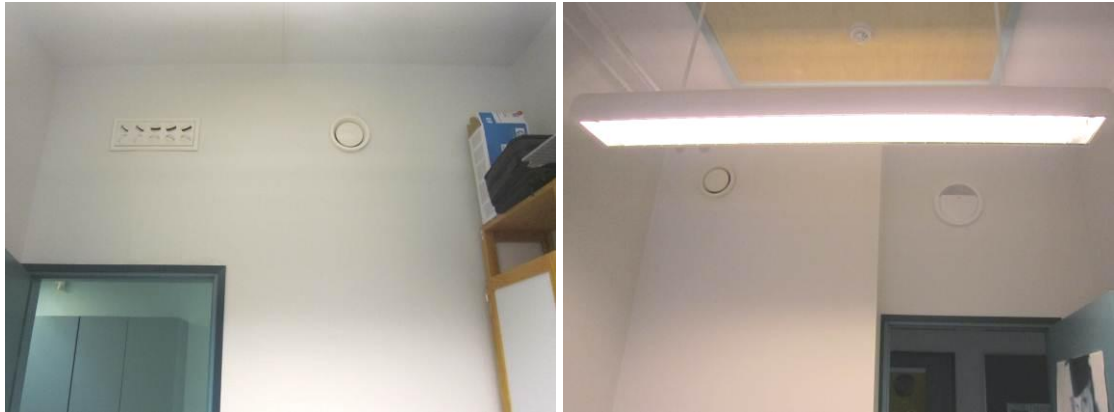
Kuva 36. Tulo- ja poistoilman pääte-elimissä ei havaittu pölyä.
