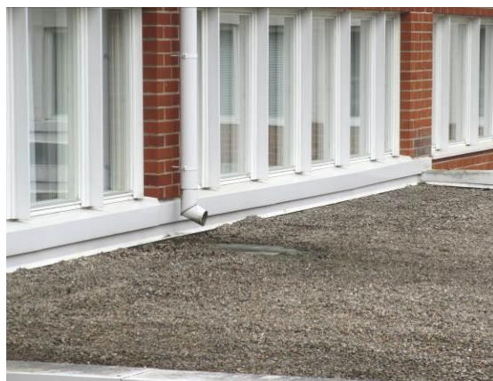
Kuvat 29 a ja b. Syöksytorvien kohdalla sorakerros on siirtynyt pois ja bitumikermi on halkeamia. Pellityksen ylösnoston kohdalla ohutrappaus on irronnut seinässä.
