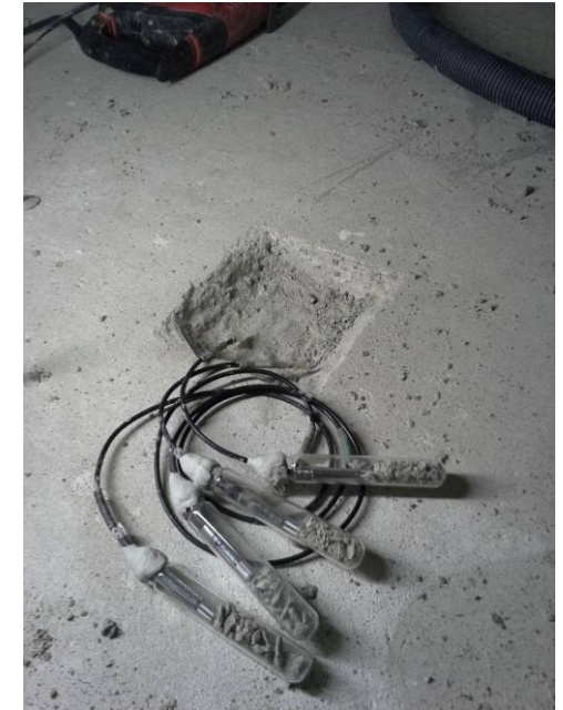
Betonin kosteusmittaus näytepalamittauksena
