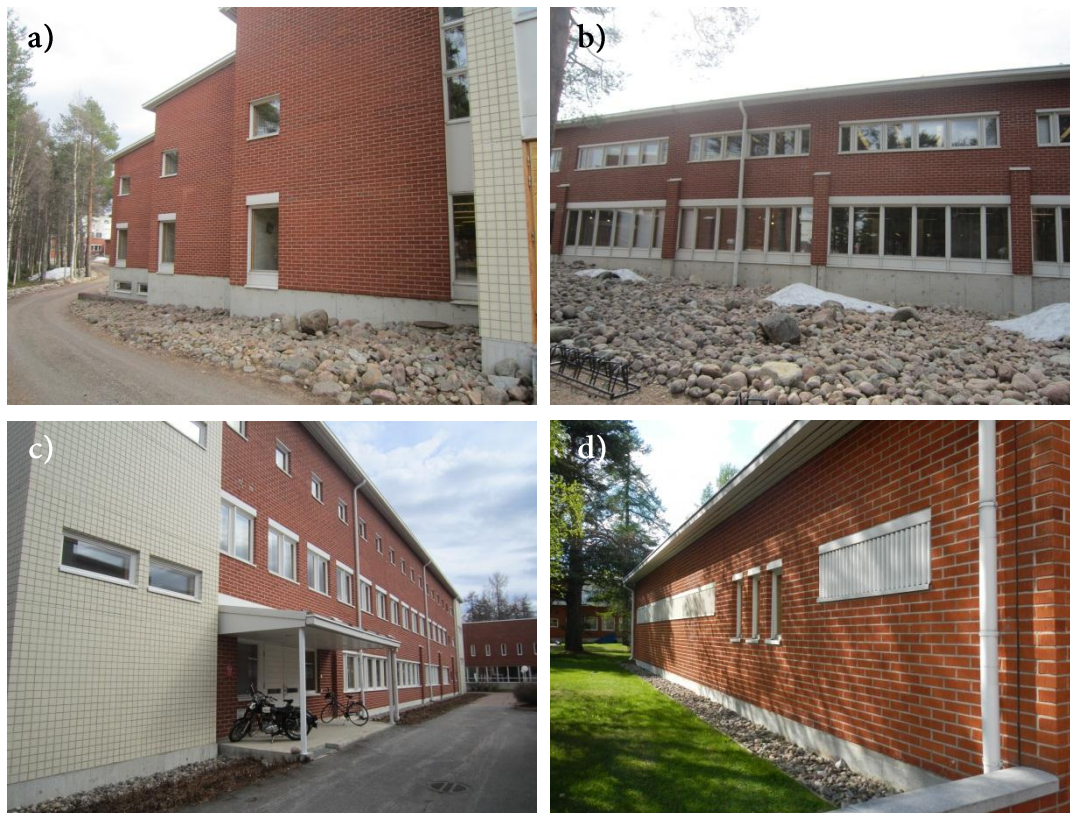
Kuva 14. Yleiskuvaa julkisivuista. a) pohjoispääty, b) kirjaston itäjulkisivu, c) kirjaston länsijulkisivu, d) eteläpääty.
