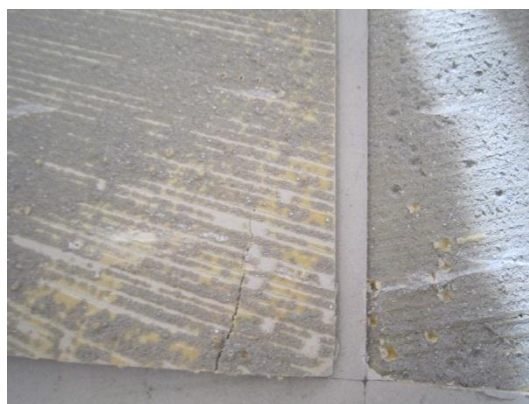
Kuva 42. Huoneen B210 lattiapäällystettä irrotettiin alustan kunnan tarkastamiseksi (Ra 2.10). Liimakerros oli reuna-alueilla kellertävää, mutta selviä, poikkeavia hajuja ei havaittu. Tasoitekerroksessa oli havaittavissa pieniä kuplien aiheuttamia koloja.
