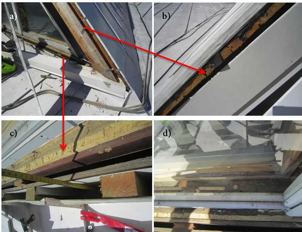
Kuva 51. Kirjaston kohdalla olevien kattolyhtyjen pellitysten toteutuksen ja vedenpitävyyttä selvitettiin rakenneavauksin.
