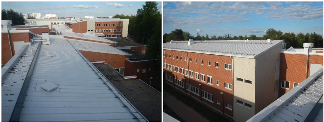
Kuvat 47 a ja b. B- siiven peltikattoja. Vasemmalla kuvassa etelälapteen loivempia 1:6 peltikattoja ja oikealla kuvassa on jyrkempikattoinen 1:4 länsilape.
