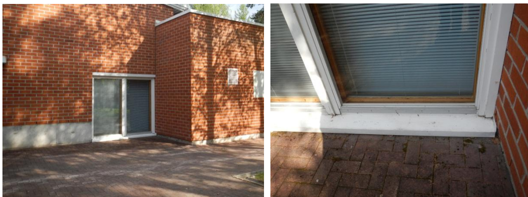
Kuva 27. Luentosalin LS3 ikkuna on lähes maantasossa. Rakenne tarkastettiin pellin alta.
