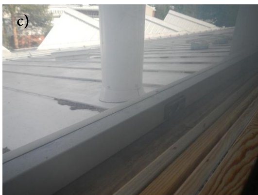
Kuva 39. Rakenneavaus Ra 3.1: 3. krs yläikkunat itäänpäin (B323). Ikkunoiden alareunan sijainti lähellä vesikaton pintaa aiheuttaa vuotoriskin. Ikkunavälissä alakarmin pinnassa oli pölyä ja kosteusjälkiä. Sisäpinnoilla huonetilan puolella ei havaittu vuoto- tai vauriojälkiä. Ikkunavälistä irrotettiin sisäverhouskipsilevy. Materiaaleissa ei aistinvaraisesti arvioiden todettu vaurioita. Rakenteesta oli voimakas ilmavirtaus huonetilaan päin.
