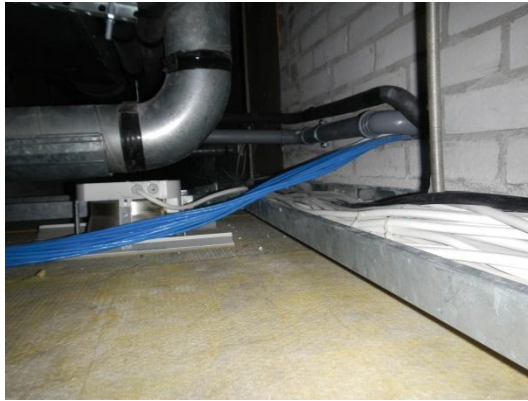
Kuva 65. 3. krs alakattoa työhuoneiden välisellä käytävällä. Alakattolevy on mahdollisesti pinnoittamatonta mineraalivillaa.
