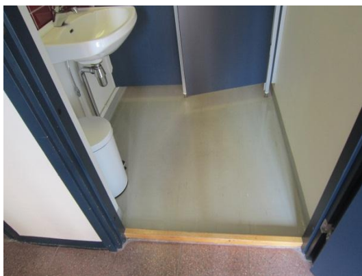
Kuva 41. Wc- ja siivoussuon lattiapäällyste on muovimattoja. Maton reunat oli nostettu seinille ja saumat olivat ehjät. Kuvat 3. krs tiloista.
