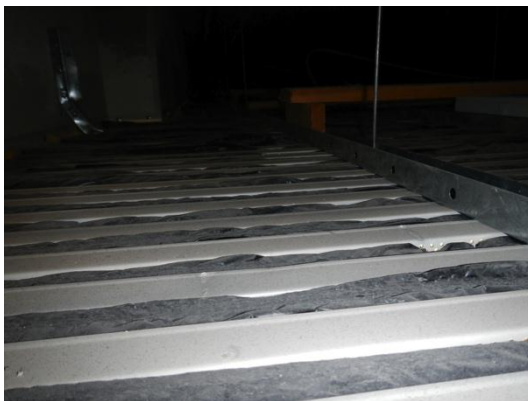
Kuva 76. Tutkituissa tiloissa oli sisäpinnoilla tavanomainen määrä laskeutunutta pölyä. Heikosti siivottuja paikkoja olivat mm. patteriritilöiden aluset ja paikoin korkeat tasot ja kaikki laskettujen kattojen päälliset.
