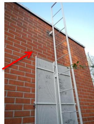
Kuva 17. Tikkaiden kiinnityskohdissa on aukot tiilimuurauksen läpi kantavaan rakenteeseen.
