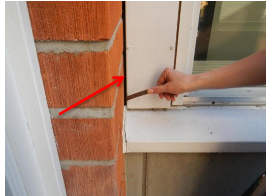
Kuva 23. Julkisivun epätiivelyskohtia ikkunaliitoksissa. Raoista saattaa päästä viistosateella sadevettä rakenteeseen.
