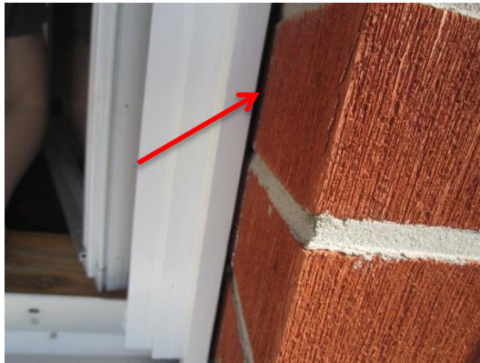
Kuva 23. Julkisivun epätiivelyskohtia ikkunaliitoksissa. Raoista saattaa päästä viistosateella sadevettä rakenteeseen.
