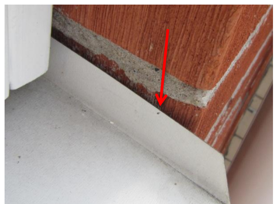
Kuva 25. Ikkunoiden vesipeltien kallistukset ovat loivat eikä peltejä ole kitattu tiiliverhoukseen sivuista.
