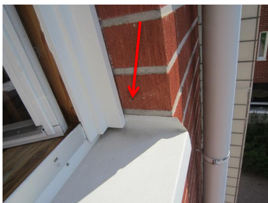
Kuva 25. Ikkunoiden vesipeltien kallistukset ovat loivat eikä peltejä ole kitattu tiiliverhoukseen sivuista.
