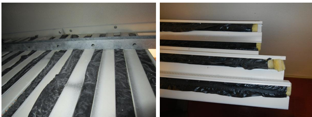
Kuva 64. Alakattojen tarkastuksia 2. ja 3. kerroksessa. Avausten kautta ei todettu vuoto-/kosteusvauriojälkiä. Alakattoritilöiden päällä oli muovitetut mineraalivillakaistat, joiden päällä oli runsaasti pölyä ja joiden päät ovat paikoin auki.
