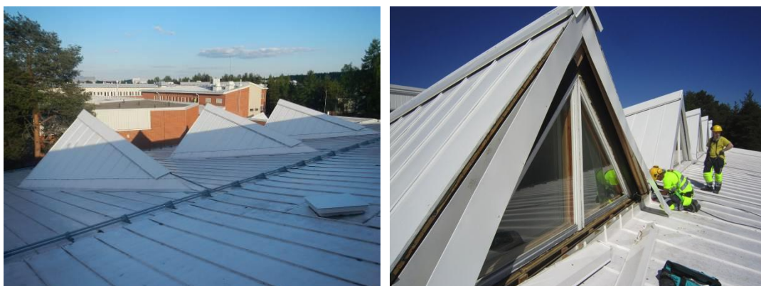
Kuva 51. Kirjaston kohdalla olevien kattolyhtyjen pellitysten toteutuksen ja vedenpitävyyttä selvitettiin rakenneavauksin.
