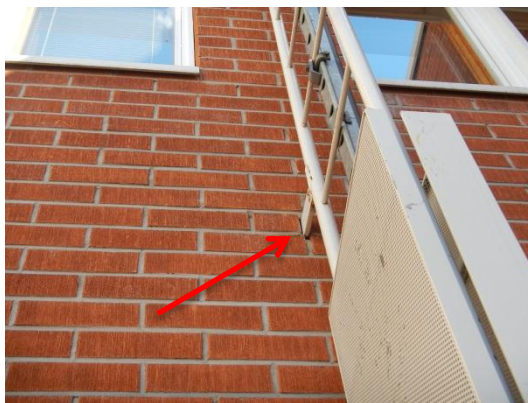
Kuva 17. Tikkaiden kiinnityskohdissa on aukot tiilimuurauksen läpi kantavaan rakenteeseen.
