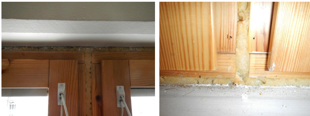
Kuva 40. Rakenneavaus Ra 3.2: 3. krs keittiötilan ikkunat länteenpäin (B302, Ra 3.2). Ikkunavälistä irrotettiin peitelista ja sen takaa tarkastettiin karmipuiden kunto ja tiivistyksen kunto ja toteutus. Rakenteessa ei todettu kosteusvauriojälkiä tai merkittäviä tiiveyspuutteita.
