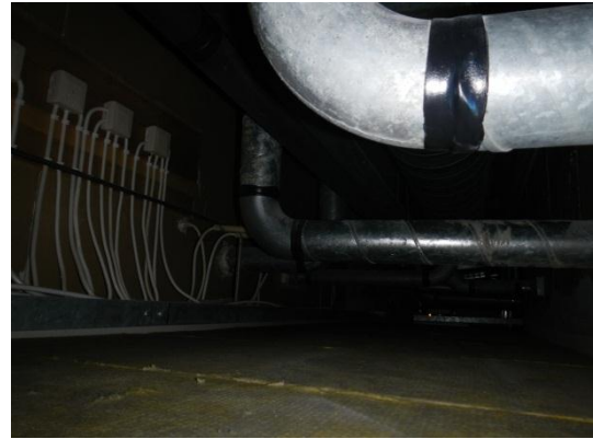
Kuva 65. 3. krs alakattoa työhuoneiden välisellä käytävällä. Alakattolevy on mahdollisesti pinnoittamatonta mineraalivillaa.
