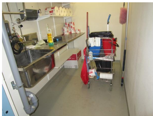
Kuva 41. Wc- ja siivoussuon lattiapäällyste on muovimattoja. Maton reunat oli nostettu seinille ja saumat olivat ehjät. Kuvat 3. krs tiloista.
