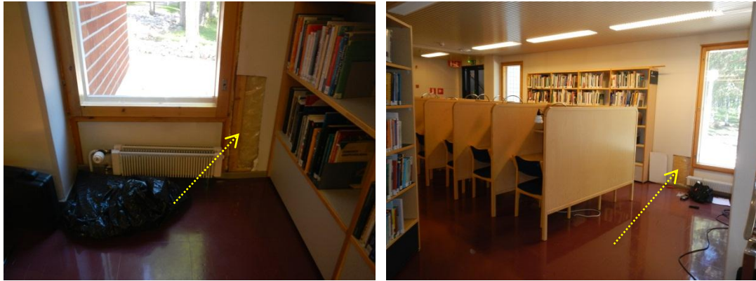
Kuva 31. Kirjastosalin pohjoispäädyn rakenneavauskohdat Ra 1.5 ja Ra 1.6a. Päädyssä on puurunkoinen, sisältä levyverhoiltu ja ulkoa tiiliverhoiltu ulkoseinärakenne. Rakenteissa oli lieviä kosteusjälkiä, mutta rakenteet olivat kuivat eikä rakenteiden riskikohdista kerätyissä kahdessa mikrobinäytteessä (M3, M5) todettu mikrobikasvua.
